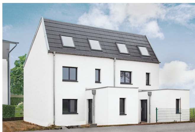
Doppelhaus-Projekt mit Stahlprofilkonstruktion: Äußerlich kein Unterschied zur herkömmlichen Bauweise.
